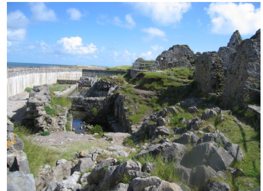
Image 4. Port Eynon, Gower, Wales. .Une saline "panhouse" du 16ème siècle. L'eau de mer est pompée dans les réservoirs de murs de pierre (centre-gauche, avec mur de défense de la mer moderne à la gauche) à un pan-house à charbon au plus haut niveau.
