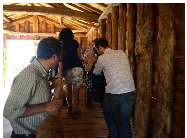
Figure 5 - Rampe d'accès à l'observatoire (problèmes détectés).
