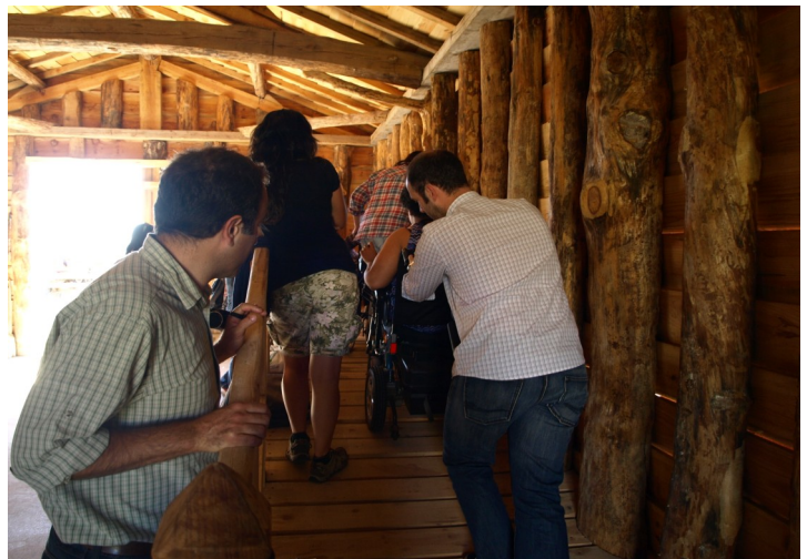
Figure 7 - Rampe d'accès à l'observatoire (problèmes détectés)
